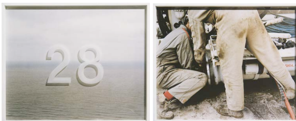
© Jean-Louis Garnell (1954-, France), Mission Photographique Transmanche n°4 , « Chantier du percement du tunnel sous La Manche », Transmanche 88 I - 28 minutes , 1988, diptyque constitué de deux images de 78,5 x 99 cm chacune, coll. du CRP.
